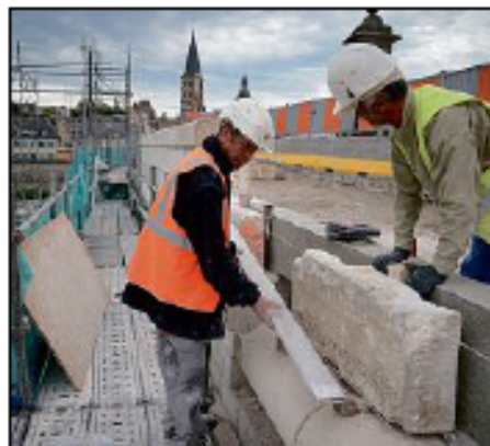
RÉFECTION. Le fin des travaux est prévu en décembre 2017. PHOTO NICOLAS BOUQUET
